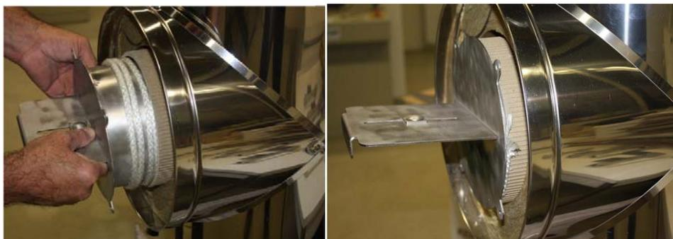
2.3 Установите розетку тройника шибера на систему Kerastar и зафиксируйте защелку хомута. Для системы Schiedel UNI на внешнюю оболочку установите рамку декоративной крышки на 4 винта.
