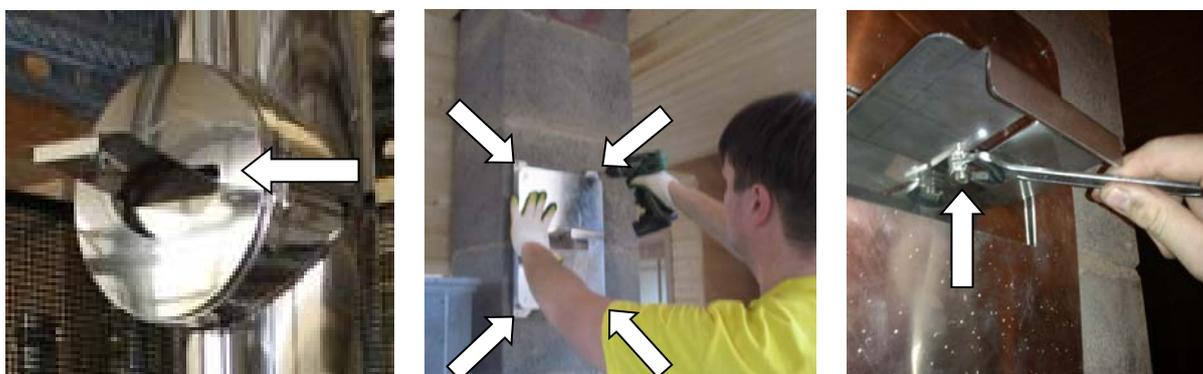
2.4 Зафиксируйте ограничительный винт ключом S13 для предотвращения механического воздействия заслонки на заднюю стенку керамической трубы.
